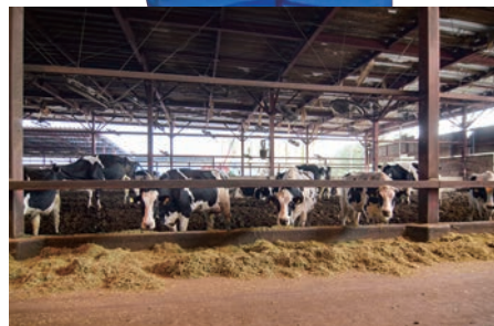
ヒートストレスを軽減するために屋根が高く設計されている。天井に溜まったガスを大型の扇風機で同じ方向に流していく。
