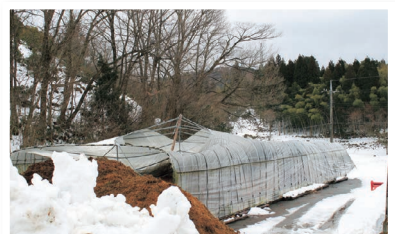
倒壊したビニールハウス
